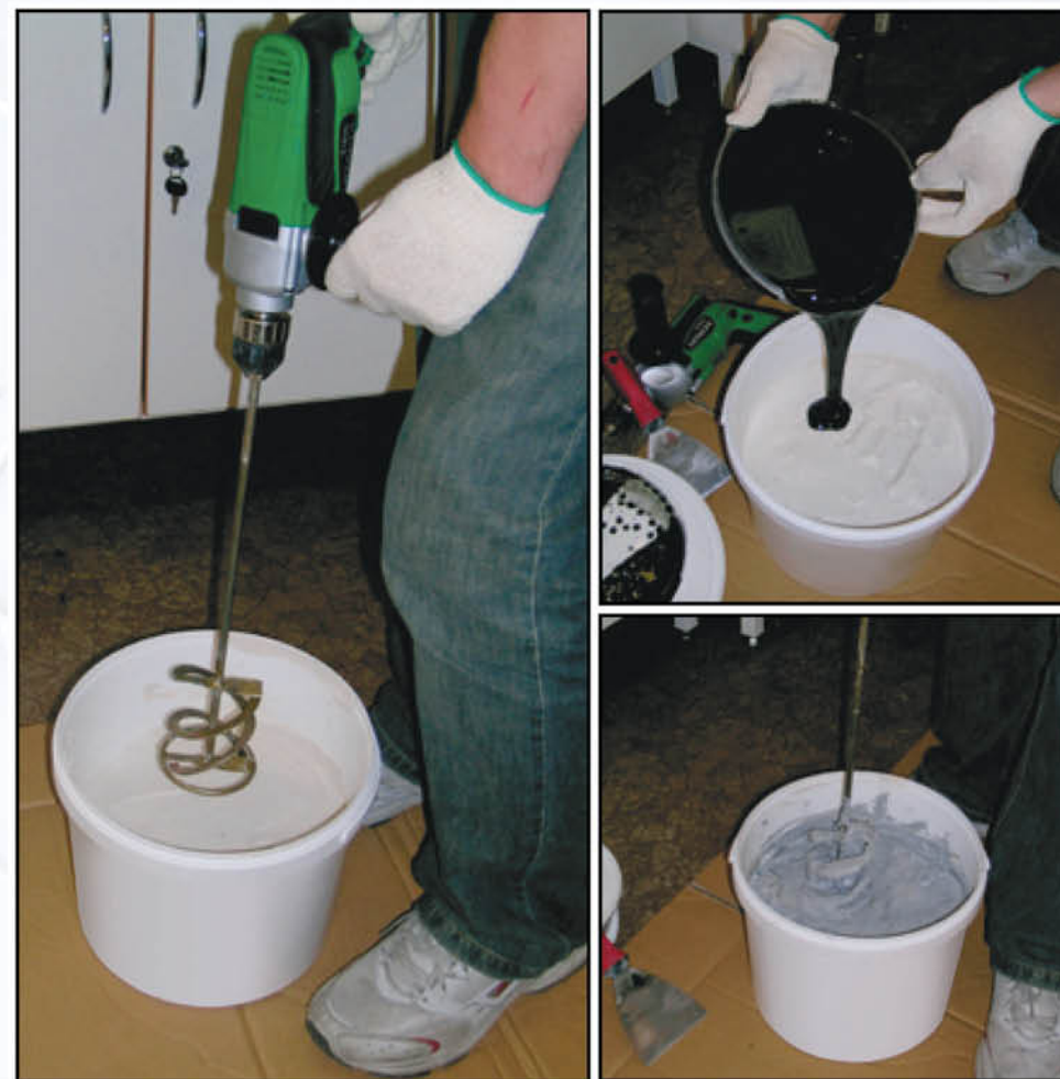
Рис. 3. Перемешивание компонентов герметика
