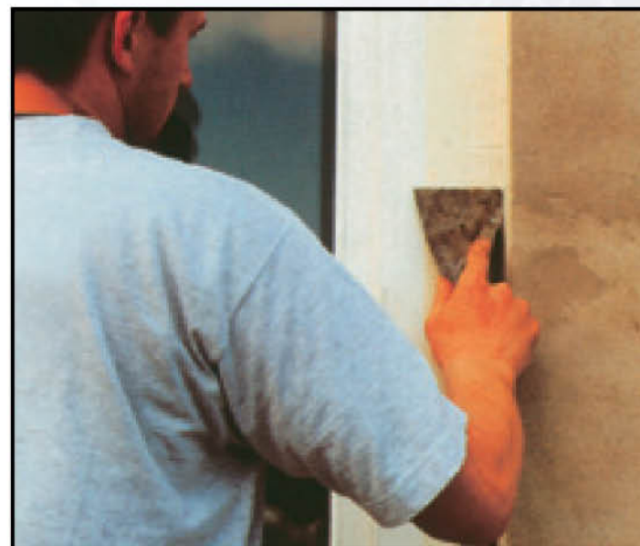
Рис. 4. Укладка и разглаживание герметика
